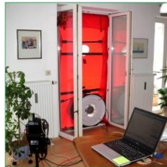
Blower Door Test
