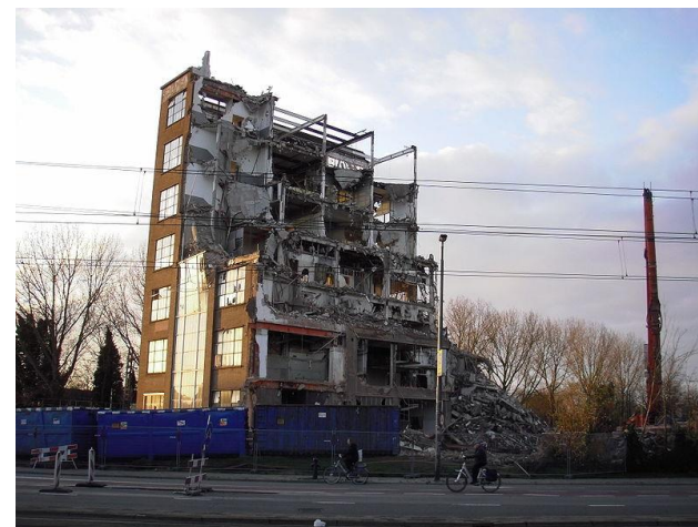
Rückbau von Wohnanlagen
